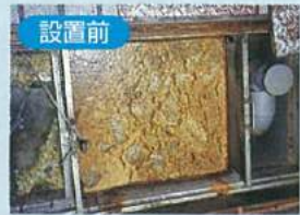
設置前 ※グリーストラップとは厨房等により排出される油脂の排水管への付着防止の為に設ける油溜めのことです。
