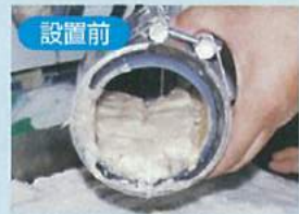
設置前 試験配管を取り外し、内部の尿石付着状況を確認
